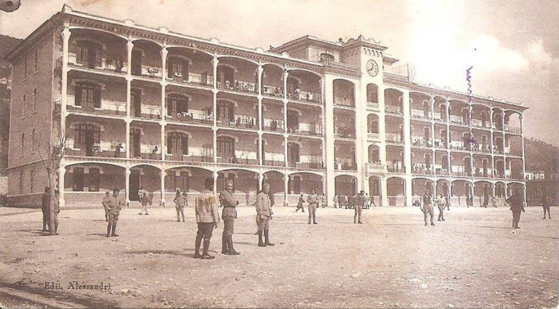
TOULON - Caserne Grignan, 8 e Colonial - Bâtiment Central
